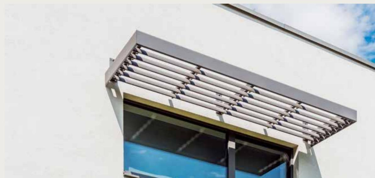
Sunclips inférieur terminé avec bandeau de finition SC. 155
